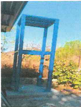
Foto 3: Instalación de estructura metálica, para colocar el tanque.
