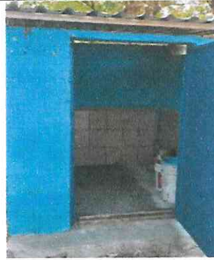
Foto 2: Colocación de costanera, lámina nueva y azulejo en el baño.
