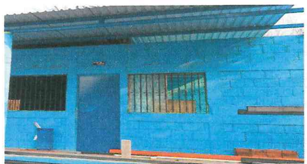
Foto 4: Mantenimiento de puertas.
