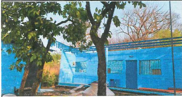
Foto 1: Mantenimiento en costaneras, para luego instalar la nueva lámina
